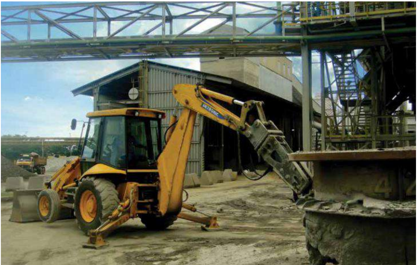
Demolição de snorkels
