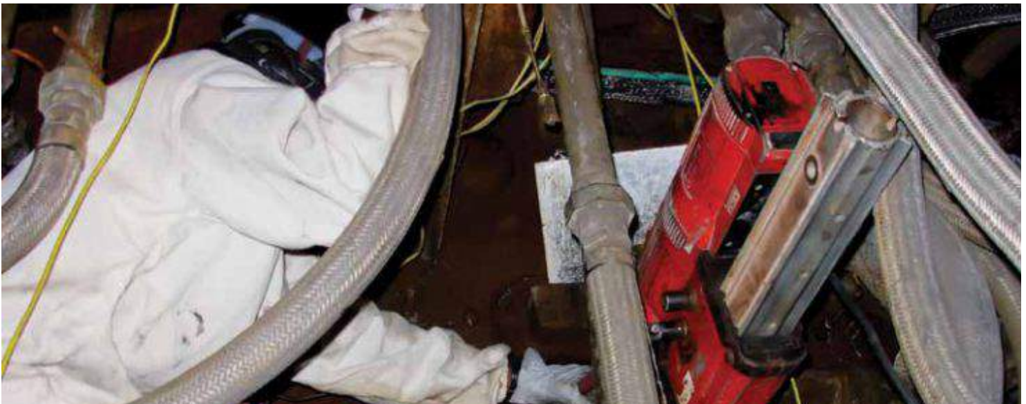
Furo em estrutura metálica com perfuratriz elétrica
