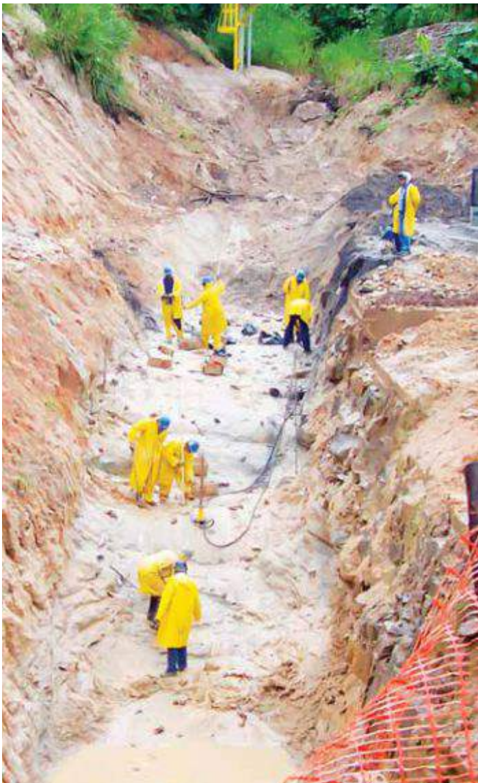
Desmorte de rocha com explosivos (fogo controlado) Rock blasting with explosives (controlled fire) / Desmorte de roca con explosivos (fuego controlado)
