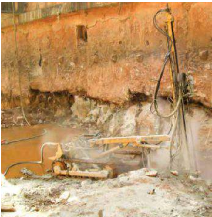
Furo em rocha com carreta de perfuração Rock drilling with drilling trailer / Agujero en roca con carreta de perforación
