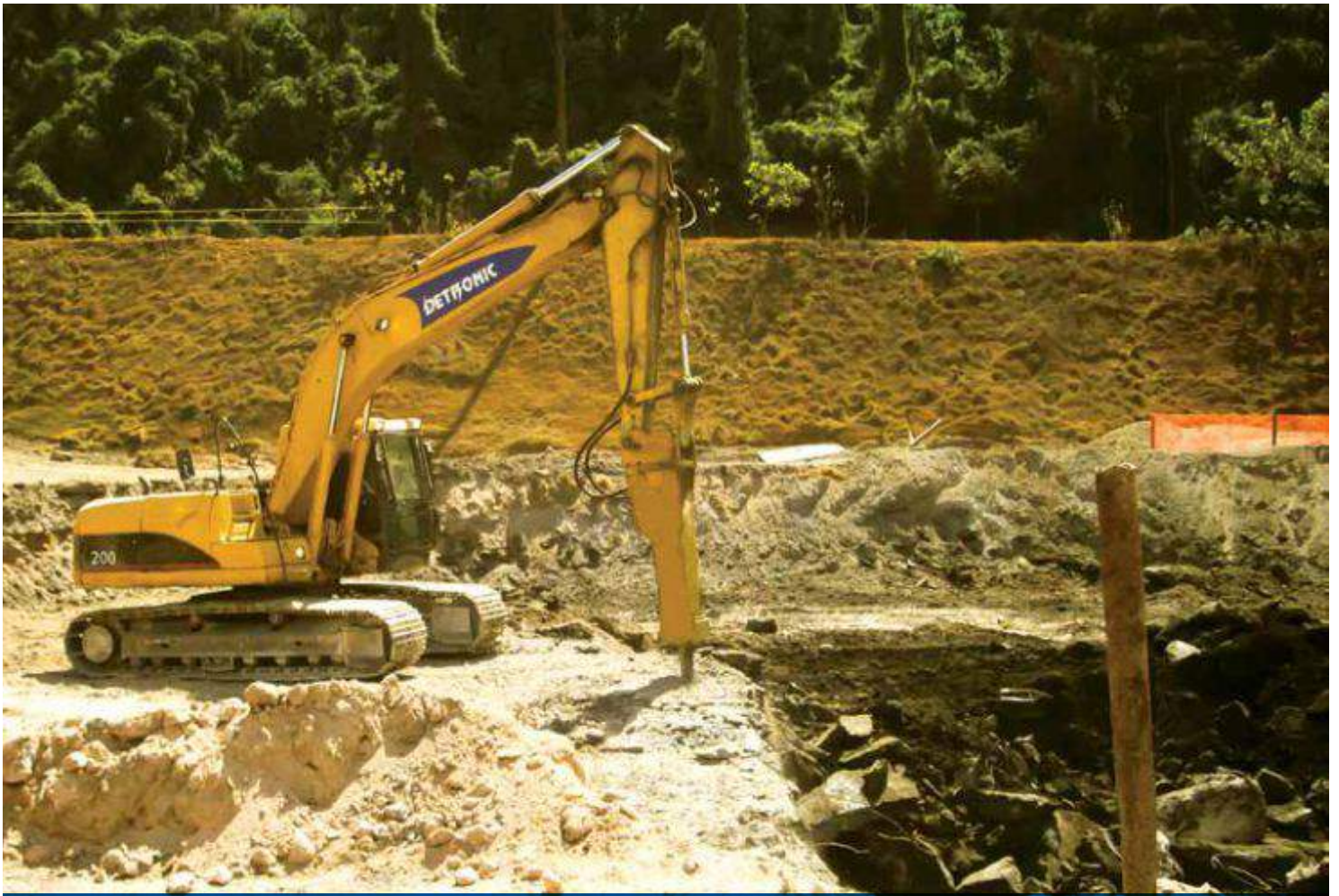
Demolição de escória compactada Demolition of compacted slag / Demolición de escoria compactada
