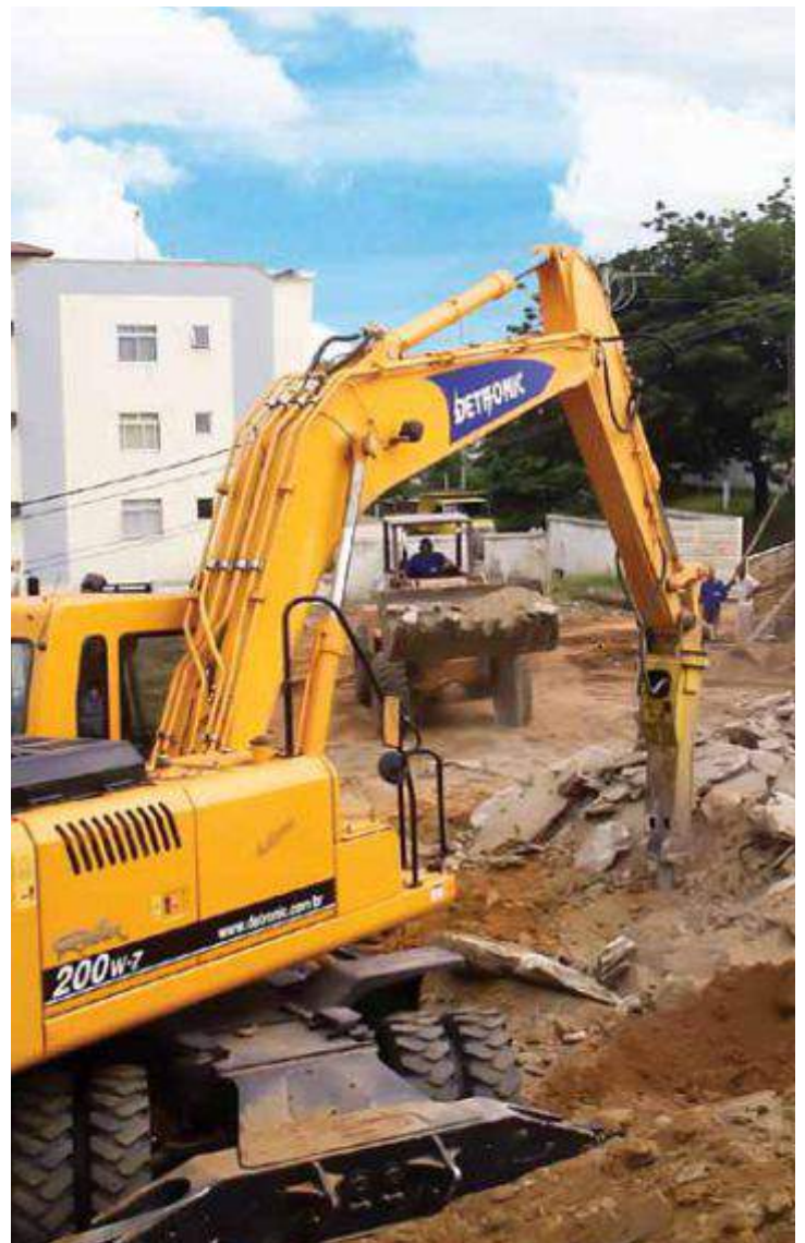
Desmorte de materiais de 2ª categoria Disassembling of 2nd category materials / Desmorte de materias de 2ª categoria
