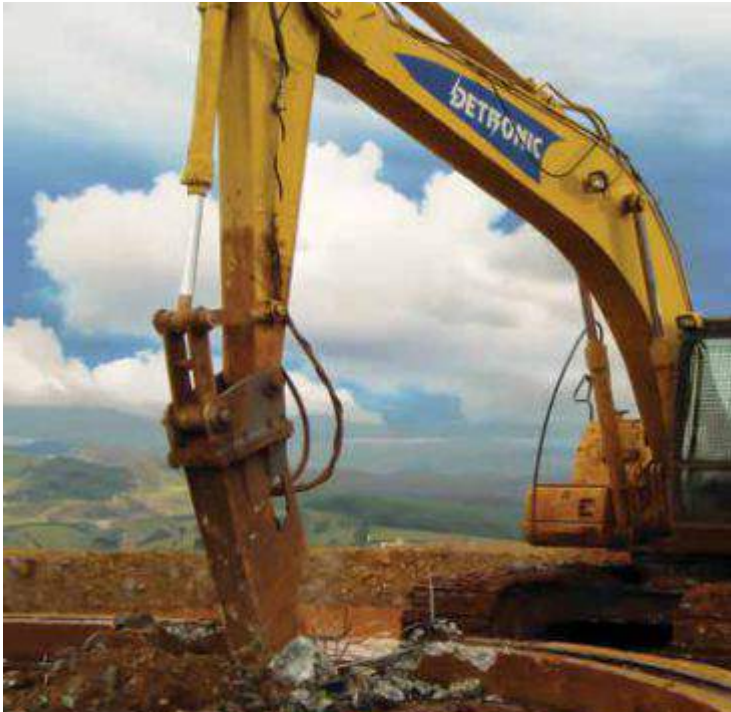
Reservatórios Reservoir / Embalses
