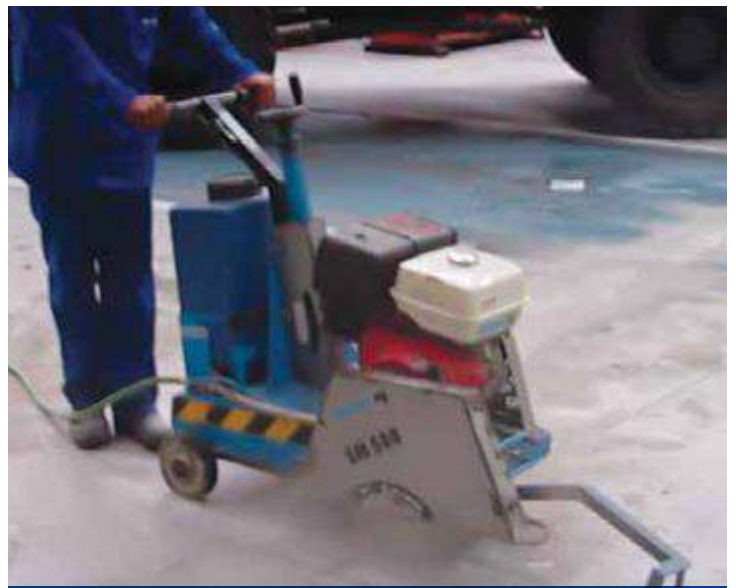
Corte em concreto com serra Clipper
