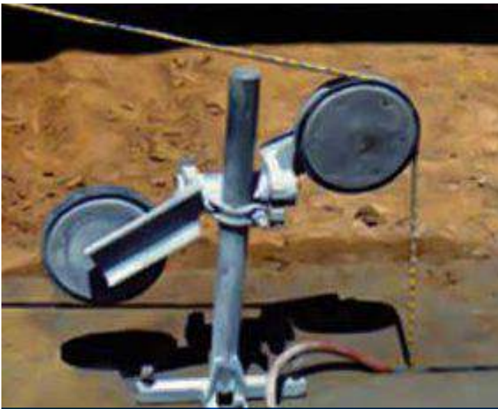
Corte em concreto com fio diamantado
