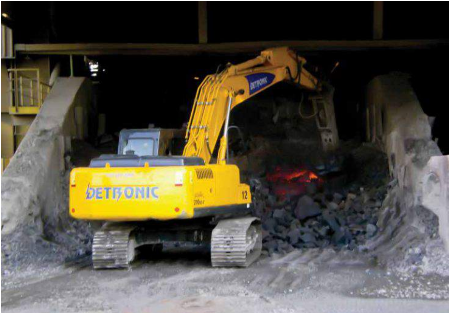
Demolição e limpeza de baía de escória de aciaria
