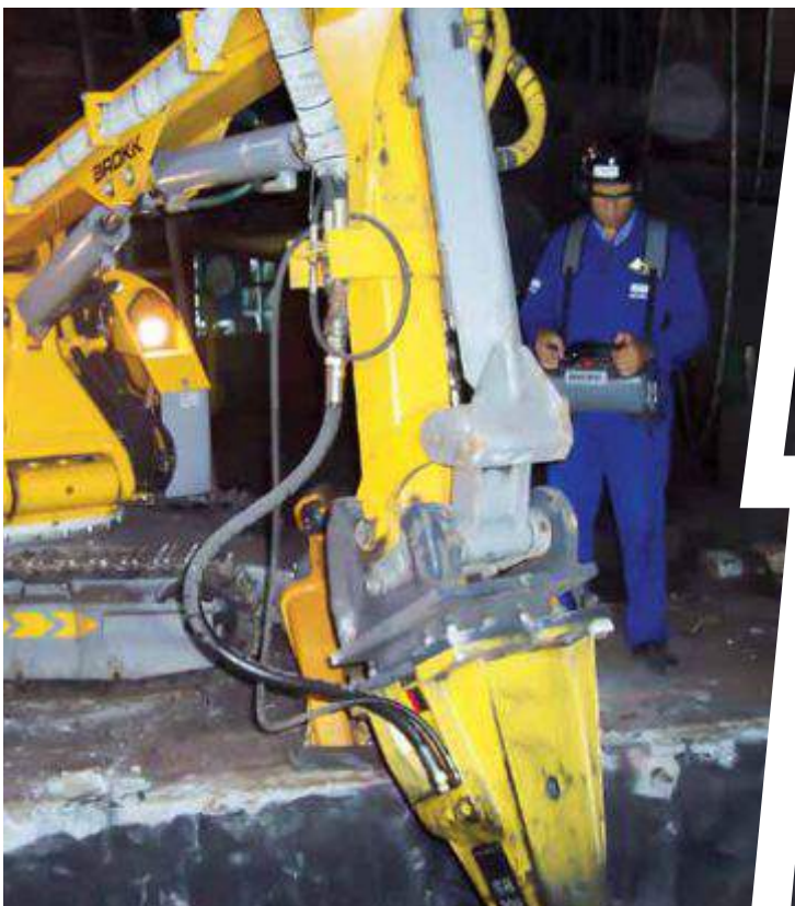
Corte e limpeza de canais de corrida
