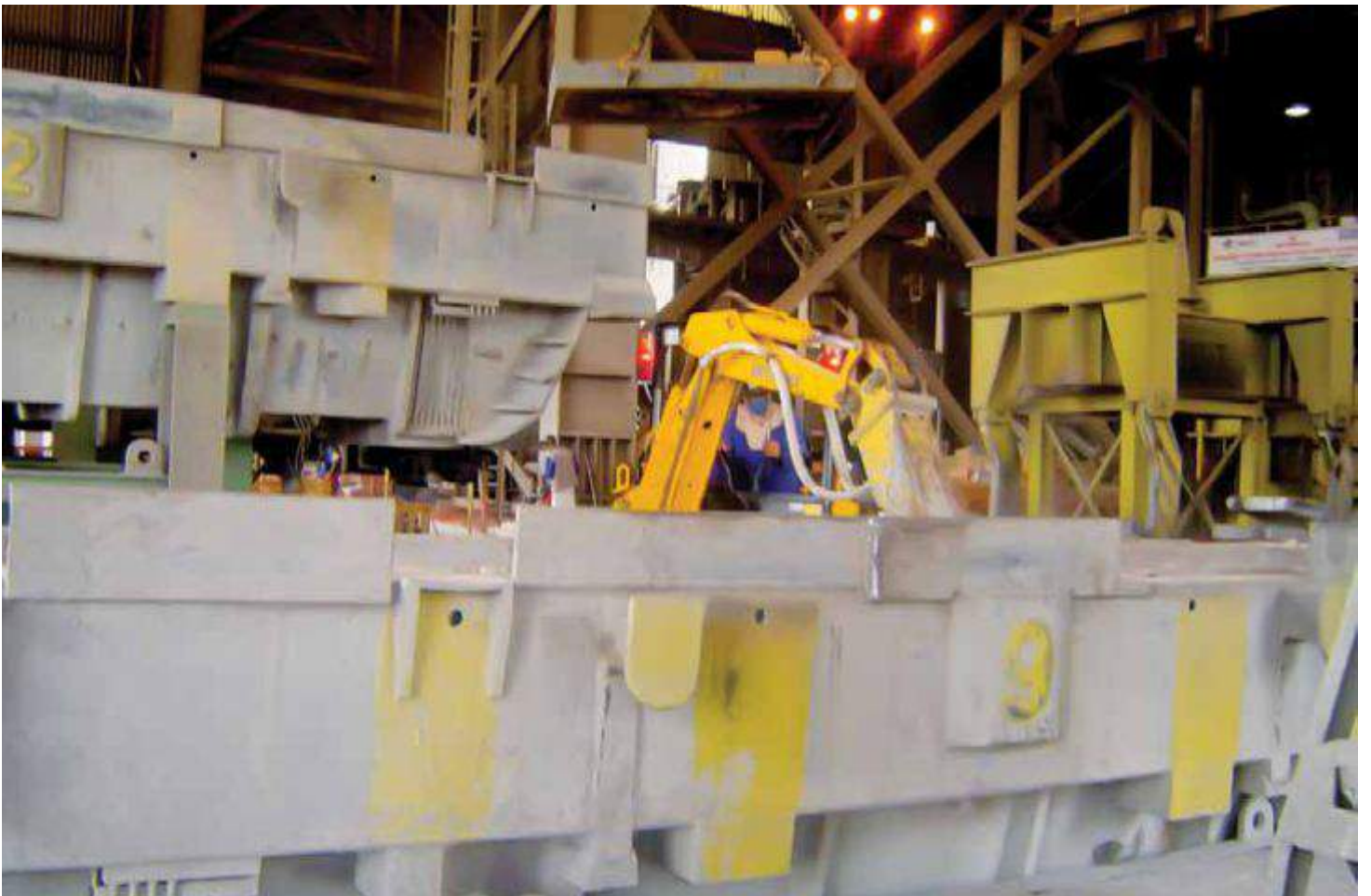
Demolição de distribuidores e tampas
