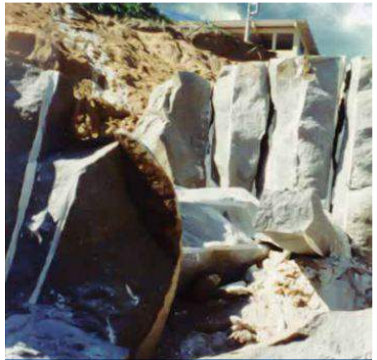
Desmorte de rocha com argamassa expansiva Rock blasting with expansive mortar / Desmorte de roca con argamasa expansiva
