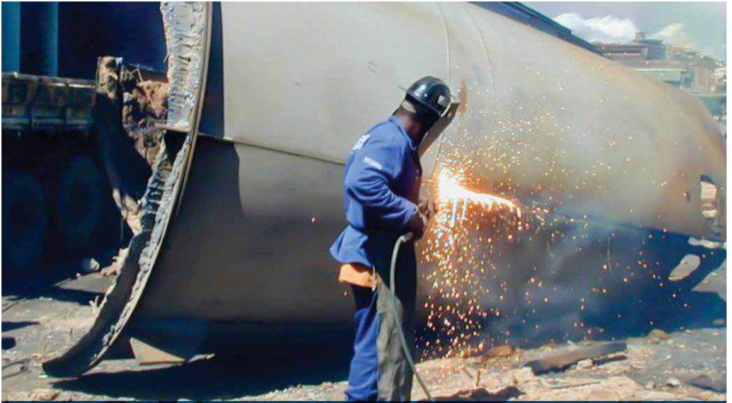
Cortes de metálicos com canhão ultratérmico Metal cutting with ultraheat cannons / Cortes de metálicos con cañón ultratérmico
