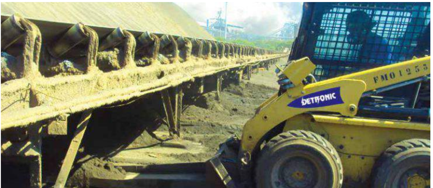
Limpeza de sistema de transportador de correias Cleaning of the conveyor belt system / Limpieza de sistema de transportador de correa
