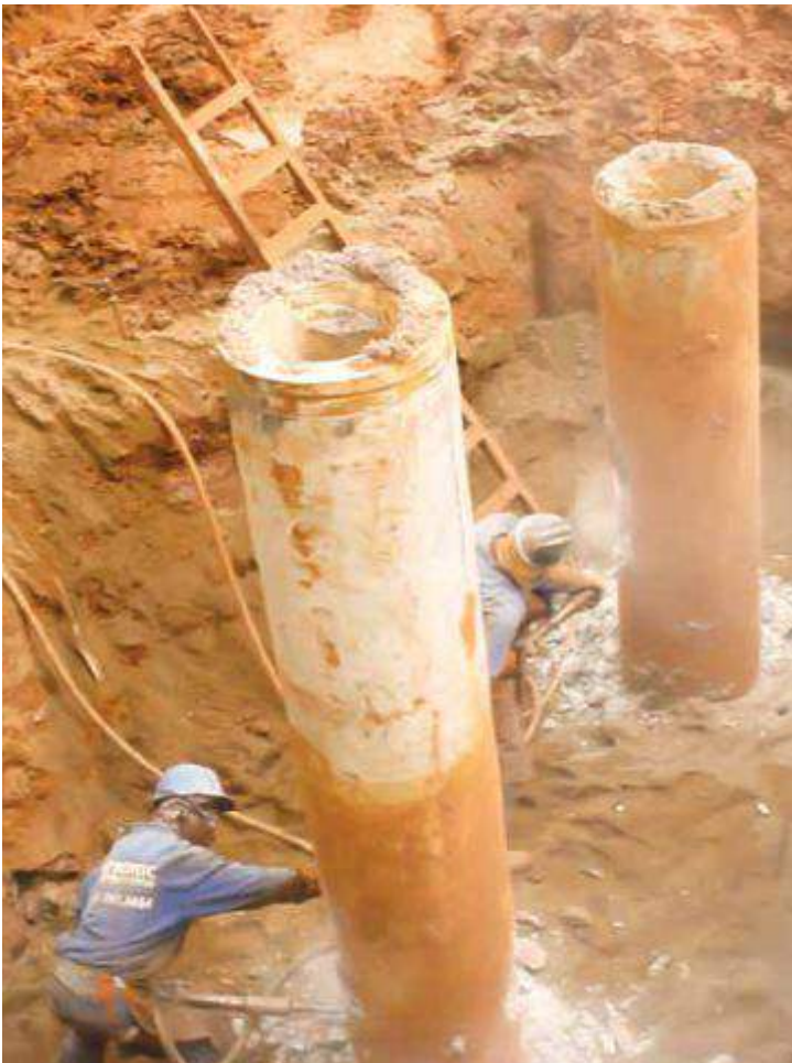
Estacas Pilings / Estacas
