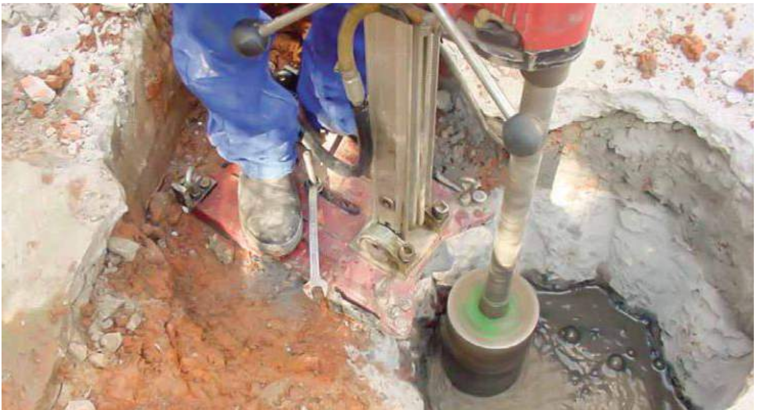
Furo em concreto e rochas com perfuratriz elétrica e pneumática Concrete and rock drilling with electric and pneumatic drill / Agujero en hormigón y rocas con perforadora eléctrica y neumática
