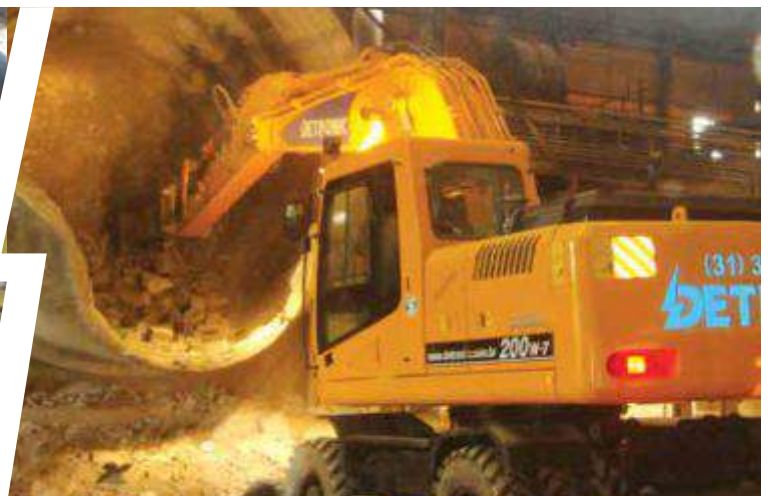
Demolição e limpeza de panelas de aço/gusa Demolition and cleaning of steel-pig iron ladles / Demolición y limpieza de ollas de acero-arrabio
