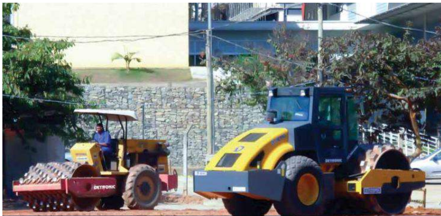
Compacção de solo Soil compaction / Compactación de suelo
