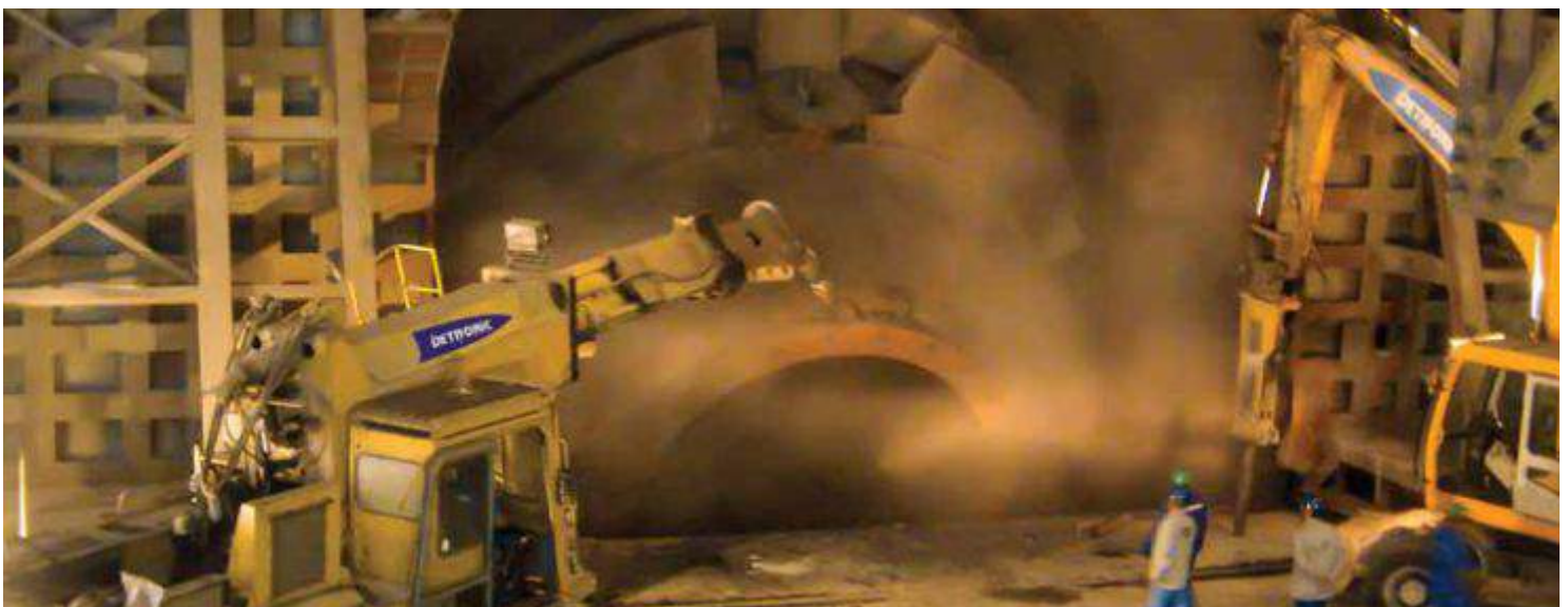
Demolição e limpeza de convertedor Demolition and cleaning of converter / Demolición y limpieza de convertidor
